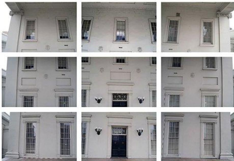
Fig. 2.2 Imagini ale unei fațade neortorectificate
